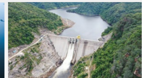
Kafue Gorge Lower Hydropower Station, Zambia
