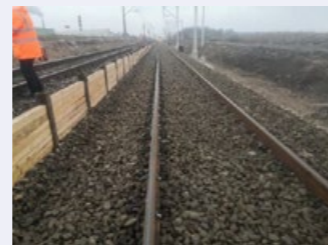
Reused old ballast
